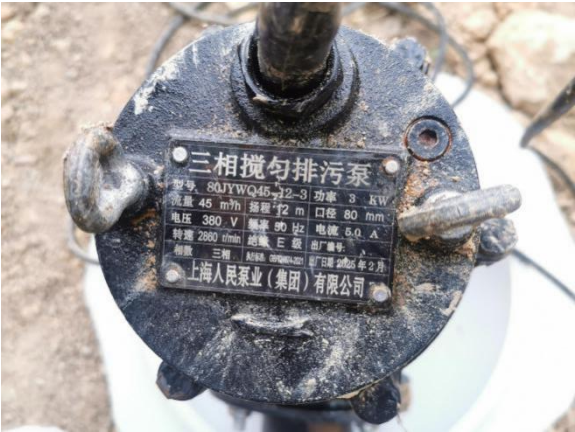
图 1 事故现场排污泵
